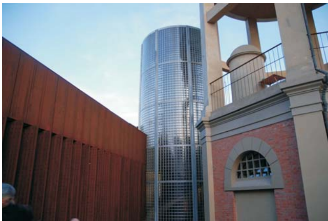
Le Torri dell'acqua
